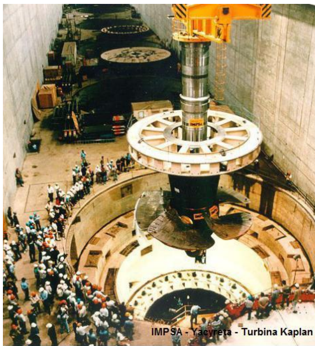
Figura 15 – 3. Imagen de una de las turbinas Kaplan, desarrolladas por IMPISA para la represa de Yaciretá.
